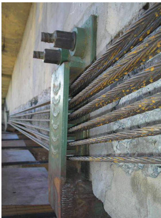
Figura 63 – Desviadores metálicos das cordoalhas na parte superior da viga (nos apoios)
