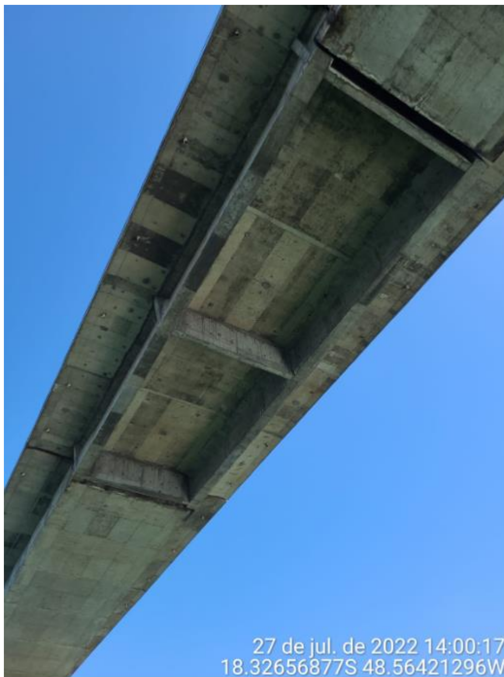
Figura 8 – Imagem (visto por baixo) do trecho pré-fabricado apoiado nas extremidades dos balanços progressivos
