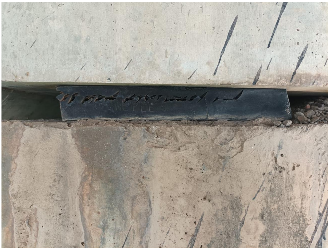
Figura 30 – Vista de um aparelho de apoio com ruptura por cisalhamento (07)
