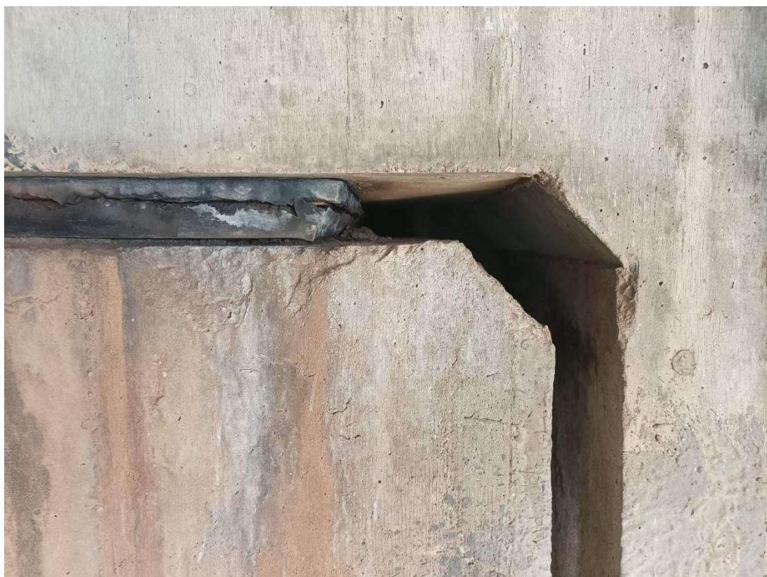
Figura 28 – Vista de um aparelho de apoio com ruptura por cisalhamento (05)
