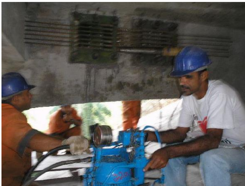
Figura 64 – Aplicação da protensão em cada cordoalha
