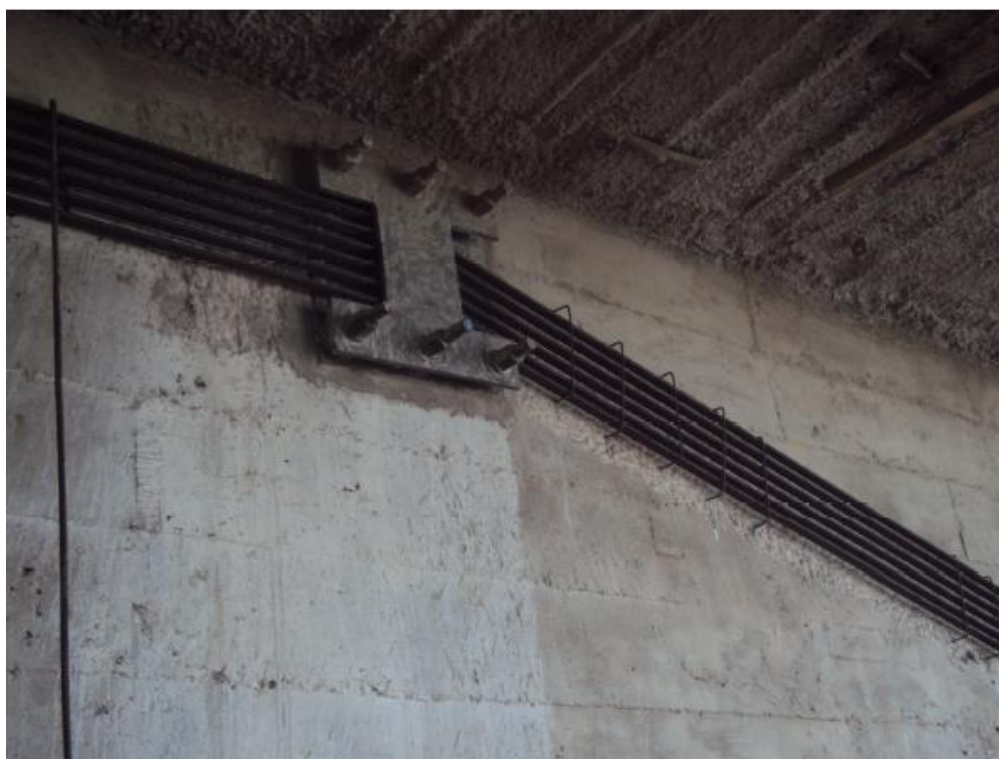
Figura 63 – Desviadores metálicos das cordoalhas na parte superior da viga (nos apoios)
