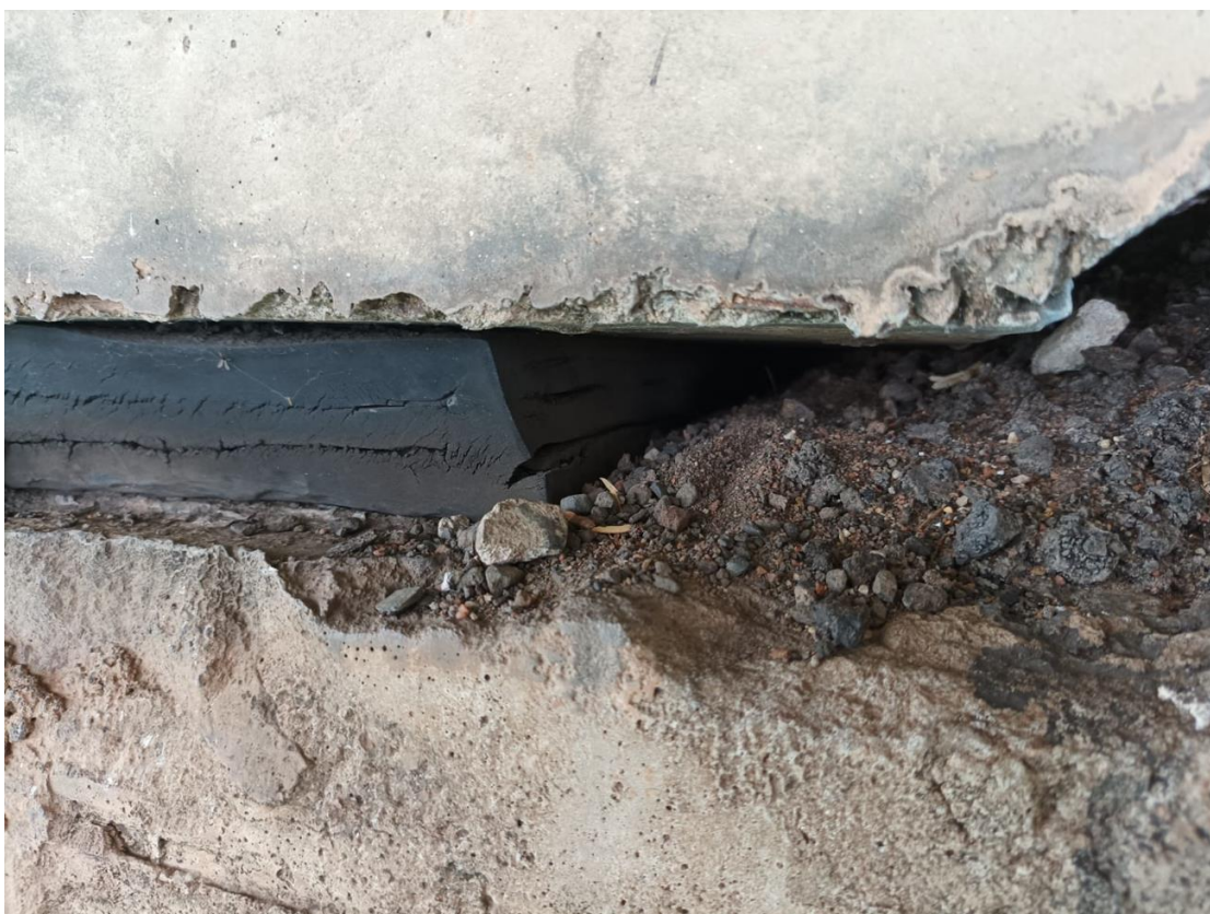
Figura 30 – Vista de um aparelho de apoio com ruptura por cisalhamento (07)
