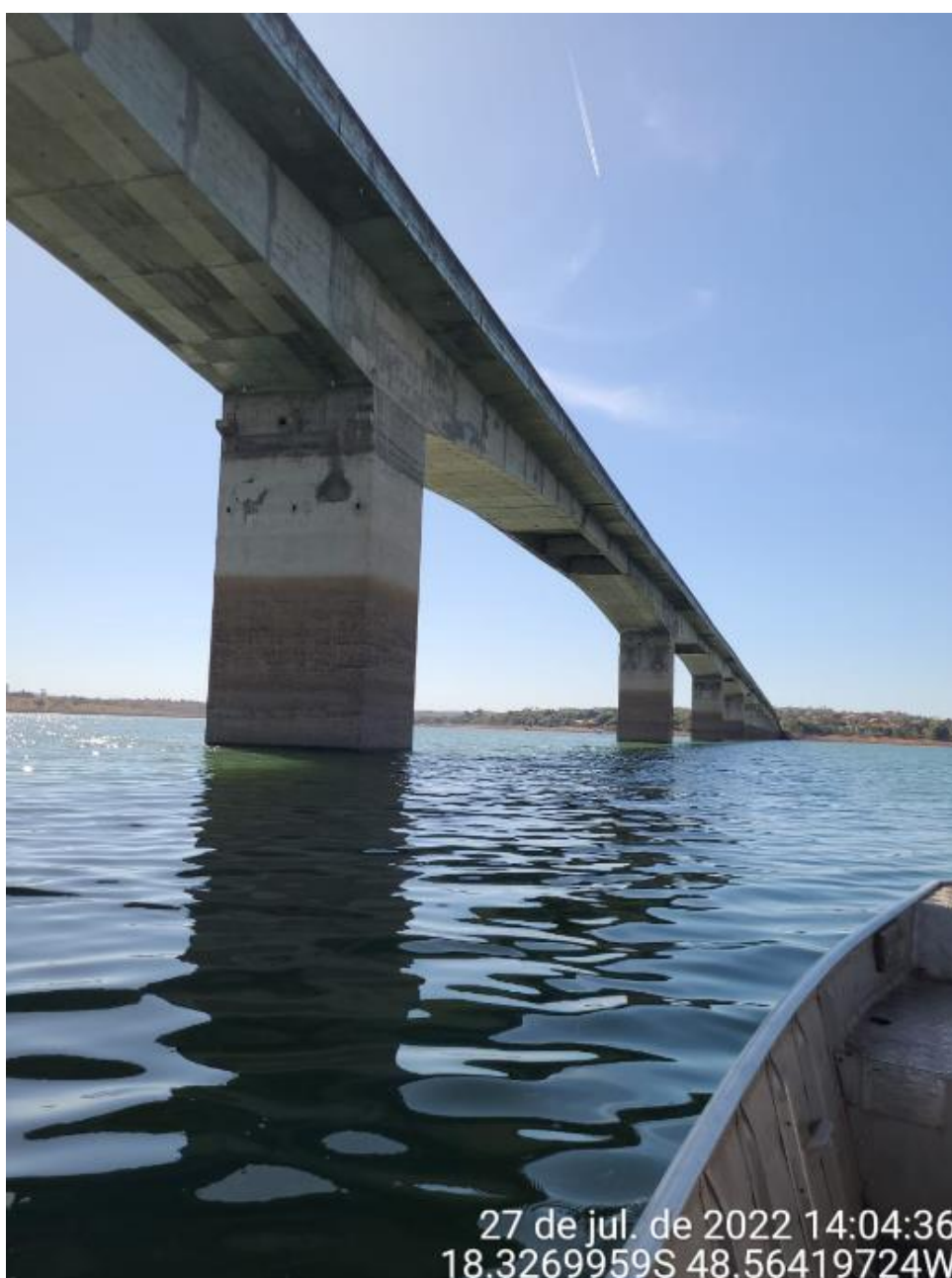
Figura 9 – Imagem dos pilares retangulares de seção vazada dos balanços progressivos
