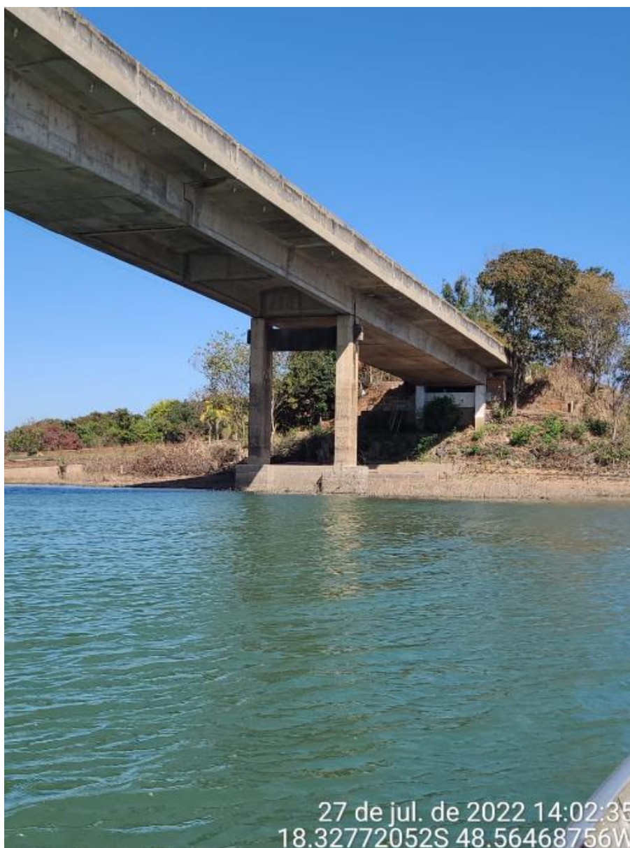
Figura 6 – Imagem dos pilares contraventados por travessa em concreto
