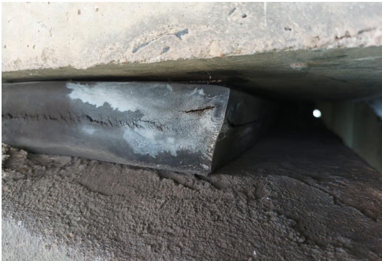
Figura 31 – Vista de um aparelho de apoio com ruptura por cisalhamento (08)
