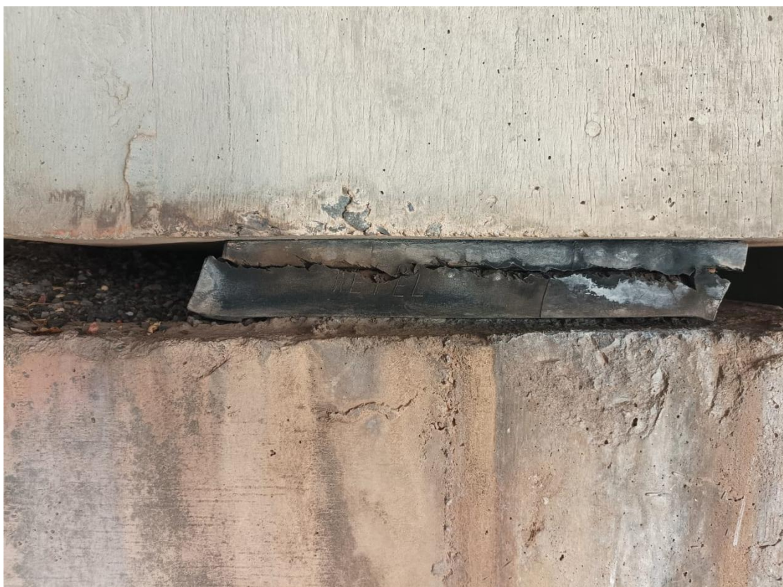
Figura 26 – Vista de um aparelho de apoio com ruptura por cisalhamento (03)
