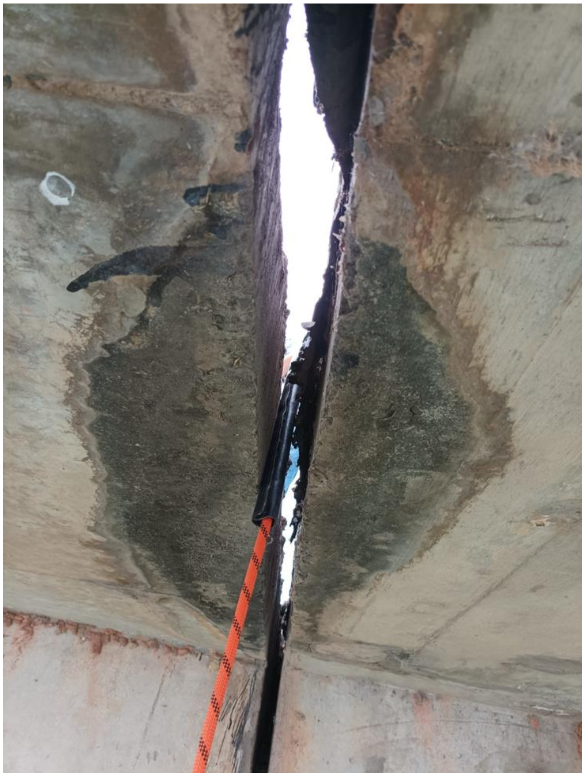
Figura 20 – Juntas de dilatação danificadas
