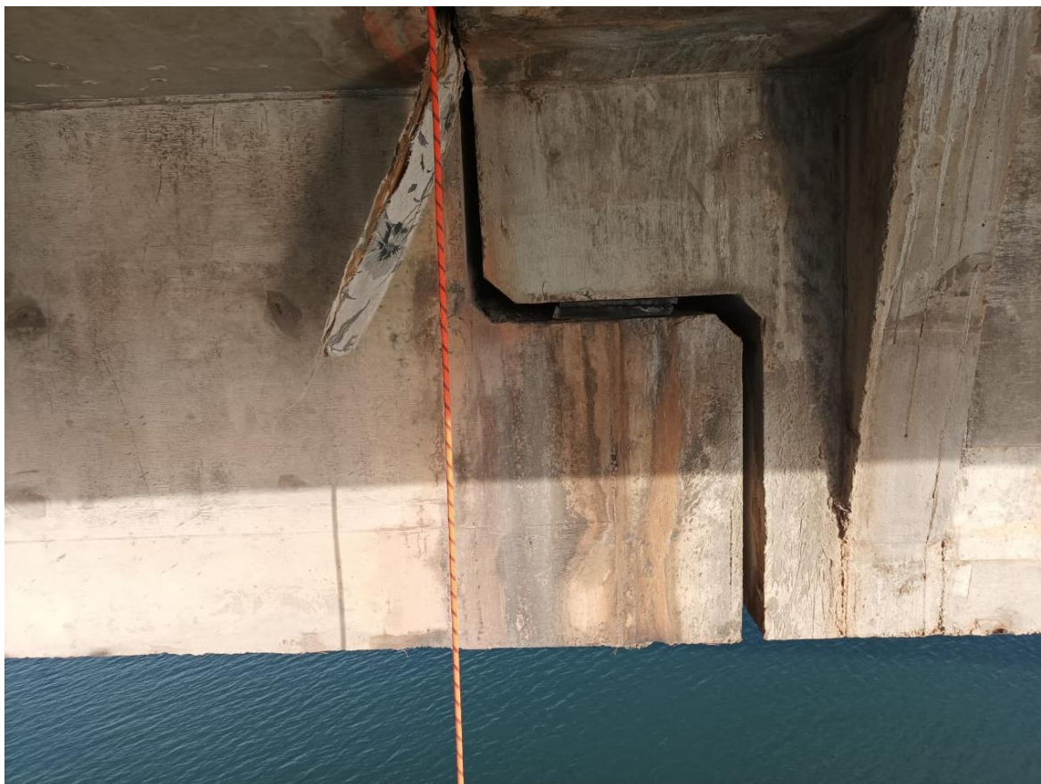
Figura 24 – Vista de um aparelho de apoio com ruptura por cisalhamento (01)
