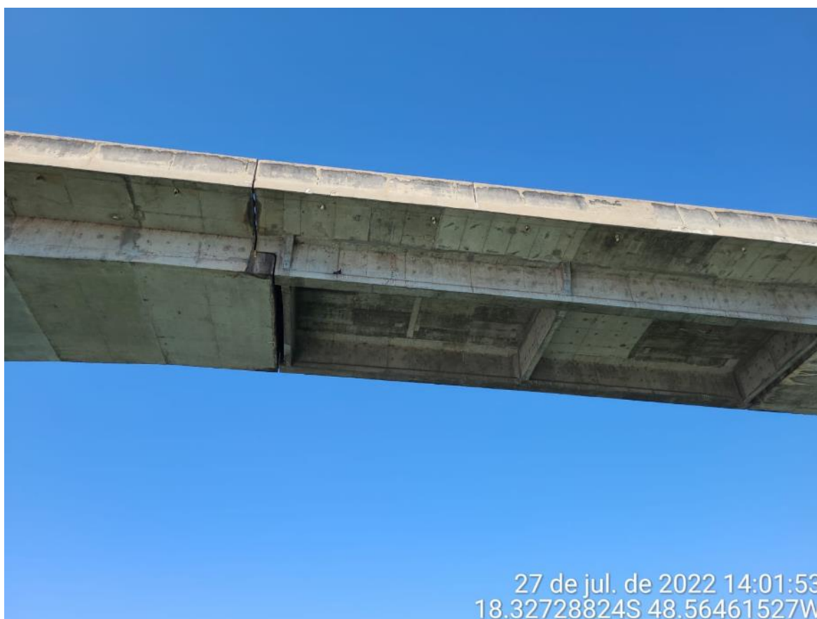
Figura 7 – Imagem do trecho pré-fabricado apoiado nas extremidade dos balanços progressivos
