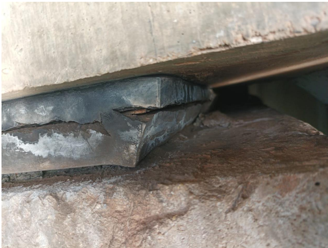
Figura 28 – Vista de um aparelho de apoio com ruptura por cisalhamento (05)
