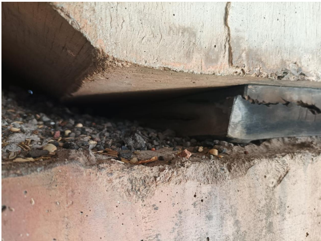
Figura 26 – Vista de um aparelho de apoio com ruptura por cisalhamento (03)
