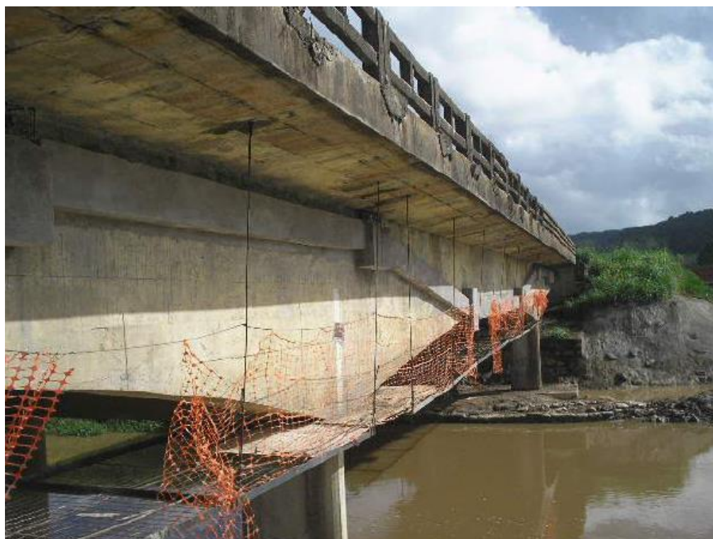
Figura 65 – Reforço e envolvimento das cordoalhas e desviadores metálicos com concreto após conclusão dos serviços
