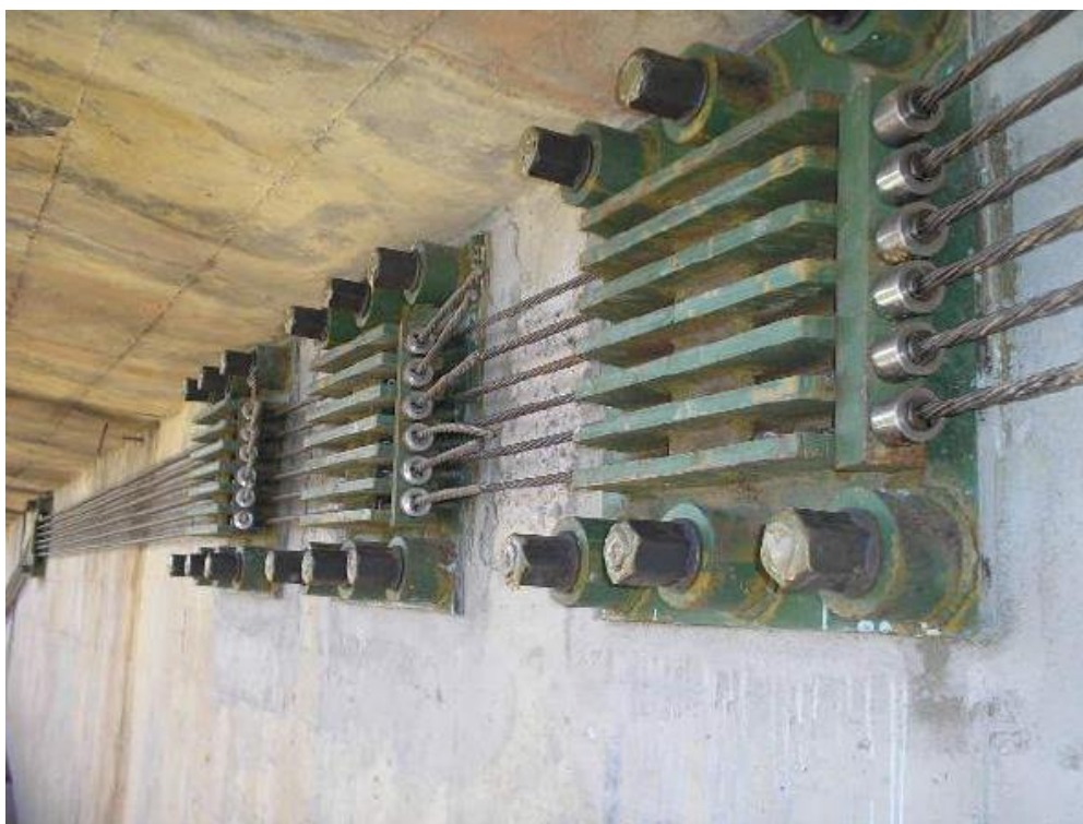
Figura 61 – Dispositivos utilizados para a ancoragem das cordoalhas nas extremidades da viga, fixadas por meio de barras Dywidag
